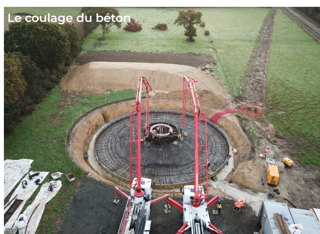
La fondation et la plateforme prêtes à recevoir l'éolienne
